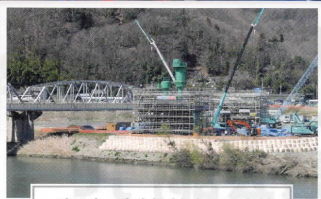
建設中の富士橋(富士川町地内)
